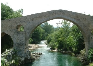
Puente romano con arco
