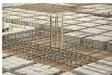
Es un material formado por arena, grava, cemento y agua que fragua y endurece, es un material MUY resistente a la compresión (gracias a la grava) y que se adhiere al acero. Esto último es lo que nos permite obtener hormigón armado, el hormigón armado se obtiene al introducir barras de acero en el interior de
